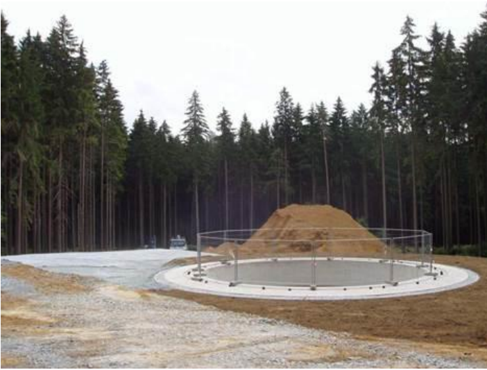
Herstellung der Aufstellfläche
