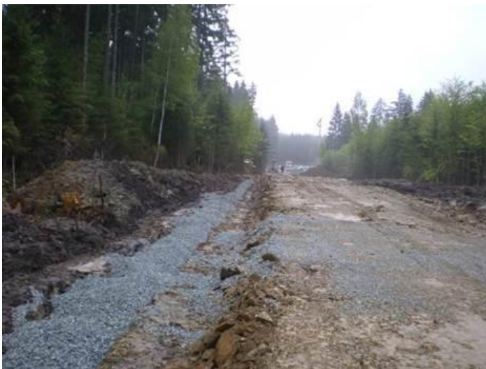
Graben für Drainage und Regenwasserableitung
