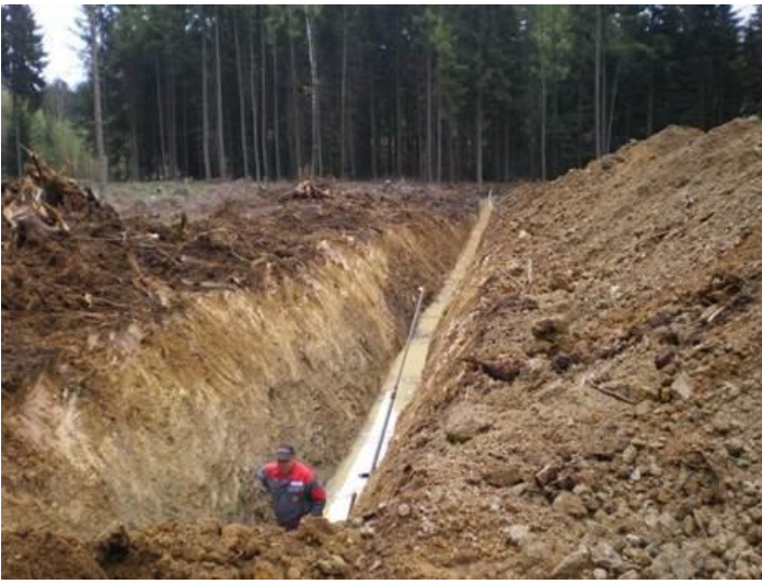
Fußdränage für Fundamentsockel
