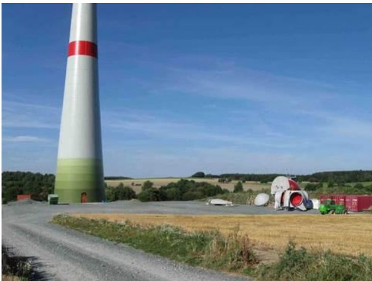
Wo früher Erholungswald war : Baustelle nach Rekultivierung könnte so aussehen
