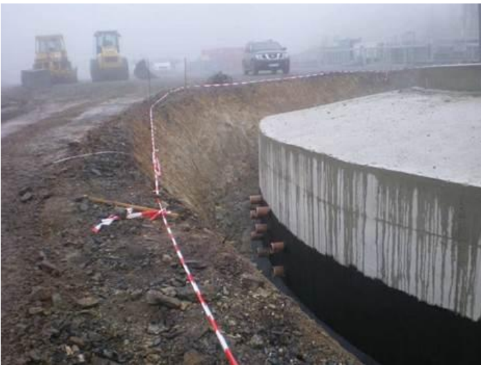
Fundament mit Ringdränage – nach Abschluss
