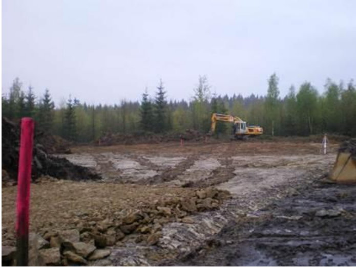
Herstellung der Baustraße (Westweg???)
