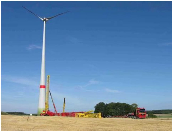
Baustelle für Endmontage der Gondel
