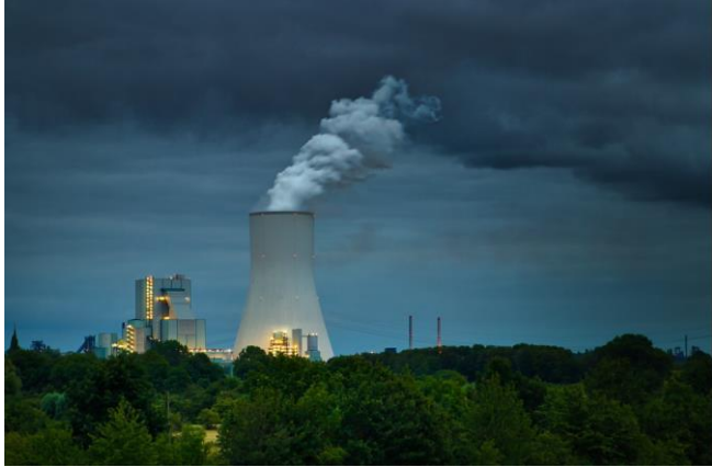
Abschaltung gesicherter Leistung
