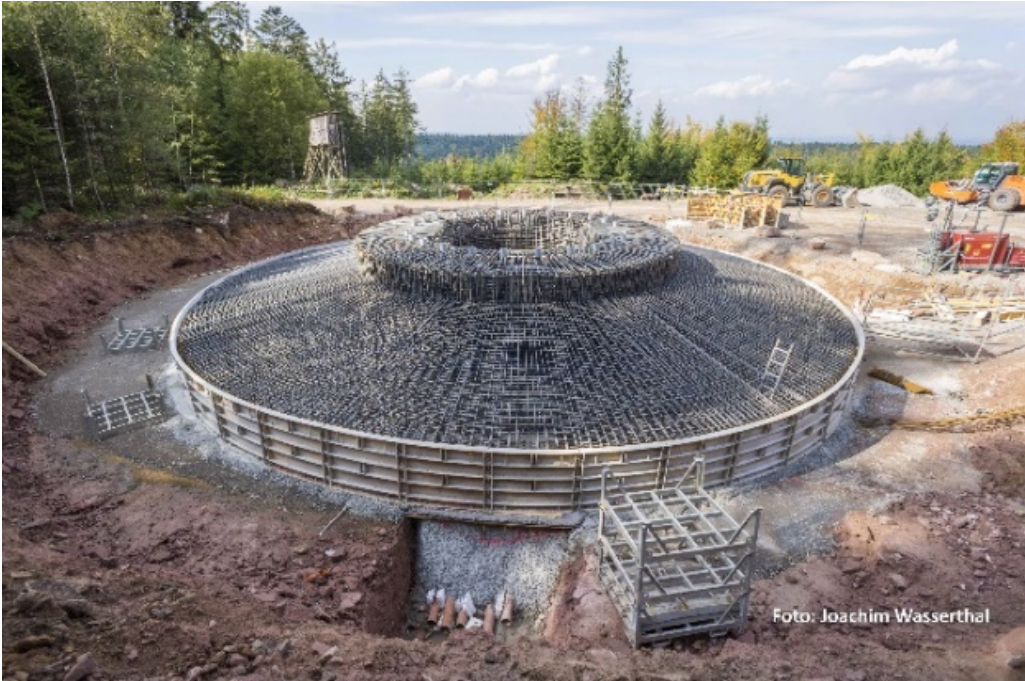
Abbildung 43: riesiges Betonfundament für ein Windrad
