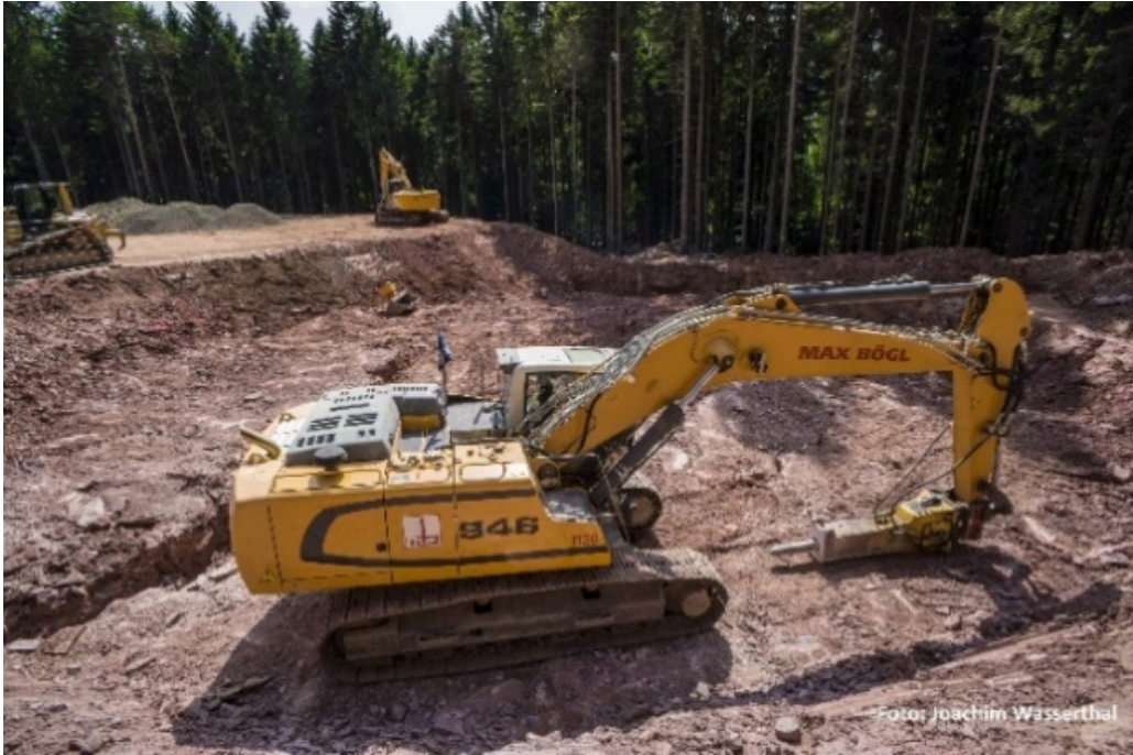
Abbildung 42: Aushub für das Fundament
